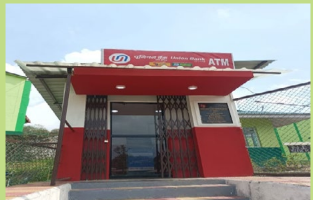
चित्र 3 सी) एटीएम सुविधा के लिए सिंगल यूनिट रूम का निर्माण
